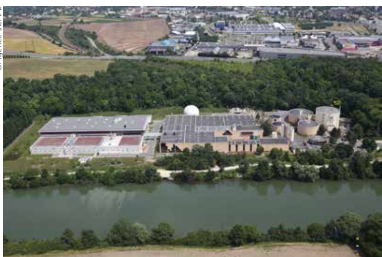
La station d'épuration de Neuville-sur-Oise traite toutes les eaux usées de l'agglomération de Cergy-Pontoise. Un chantier d'agrandissement et de remise aux normes a été terminé en 2012.
