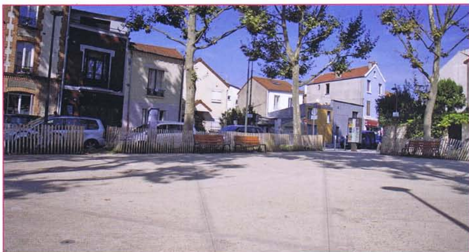
Raison du choix du béton bouchardé pour la rénovation de la place : redonner de la luminosité au lieu. Dans ce but, les platanes ont été également élagués.
