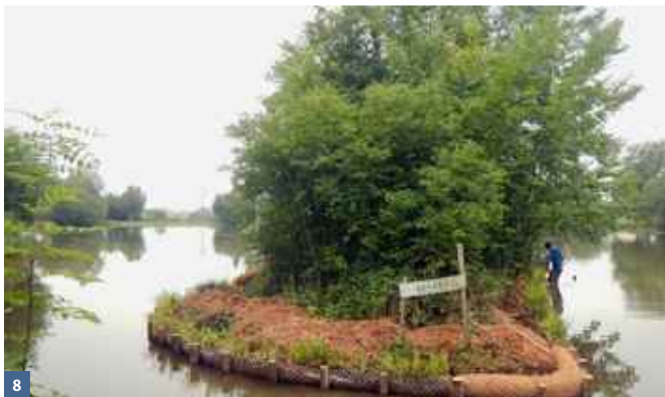
8. À Saint-Germier, le renforcement des berges de l'îlot par des boudins de coco prévégétalisés a permis de limiter les dégâts de ragondins et de créer un espace propice à la découverte de la faune.
